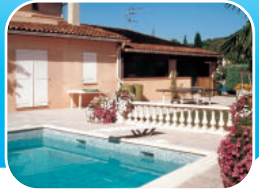
Capteurs solaires en toiture
